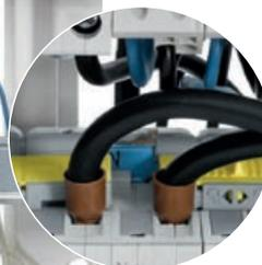
Couper la barre de pontage à cet endroit. Réaliser le pontage à l'aide d'un conducteur de section adapté et suffisamment long pour mettre en œuvre le tore sans difficulté, idéalement en utilisant les bornes de repiquage des disjoncteurs SanVis
